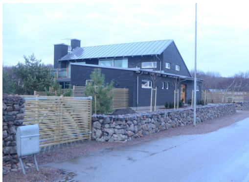
Bild 1. Nybyggt hus i lägre liggande del av Vilshärad. Fastigheten har dock höjdsatts så att dagvatten avrinner från denna mot omgivningen.
