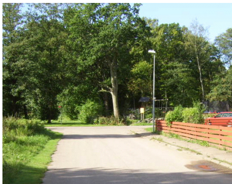
Bild 11. Veckogatan före åtgärd.
