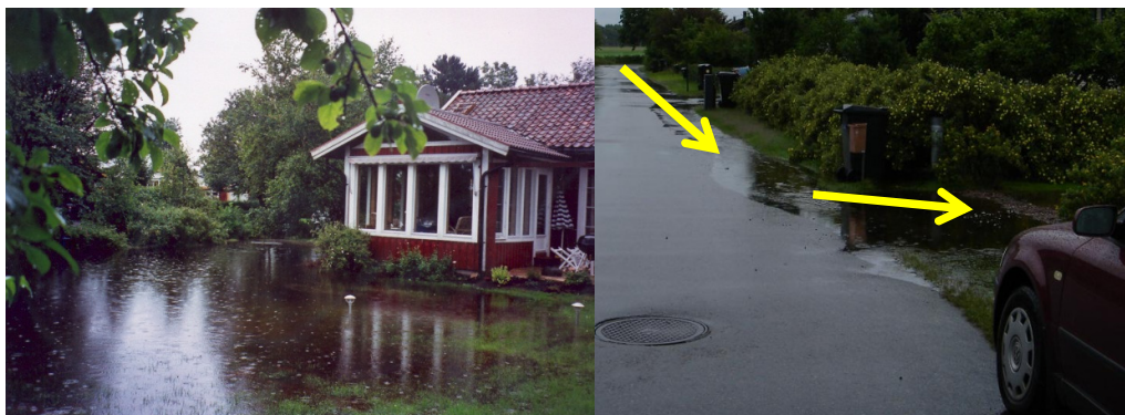
Bild 29 Höga grundvattennivåer efter långvarigt regnande och avsaknad av anslutning för bortledning av dräneringsvatten orsakar marköversvämning.
