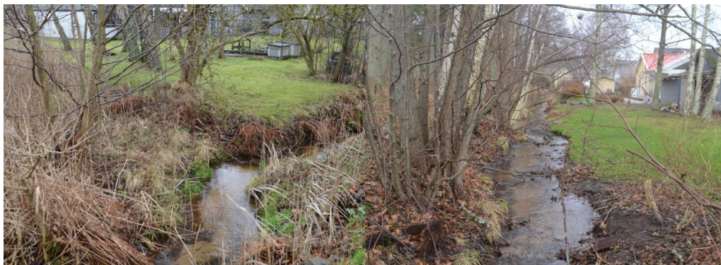
Bild 5. Avgrening (åt vänster) som nu är igensatt, flödesriktning från läsaren. Vid platsbesök låg även gräsklipp i den avskurna fåran.
