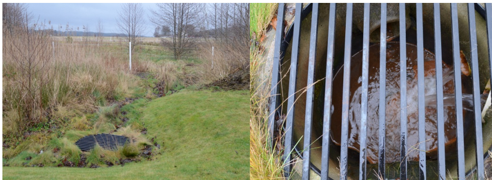
Bild 7. Intagsbrunn uppströms Storegårdsvägen efter upprepning, vallbyggnad och nytt gallerlock.
