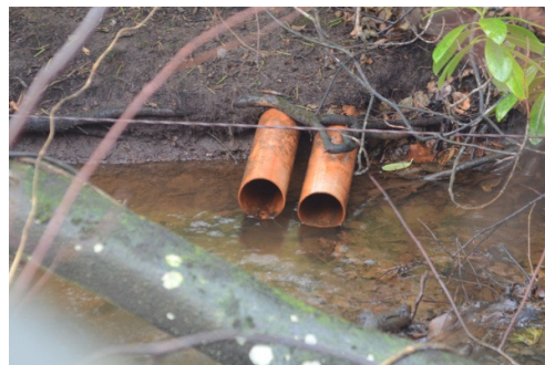
Bild 28. Inkommande nyare ledningar.
